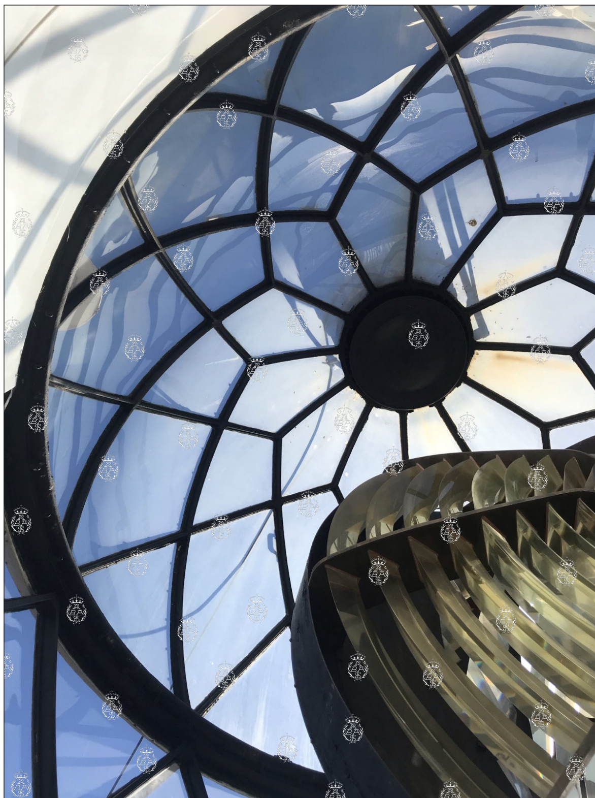
Cerramiento vítreo de la linterna. Foto P. Navascués / M. C. Utande.
