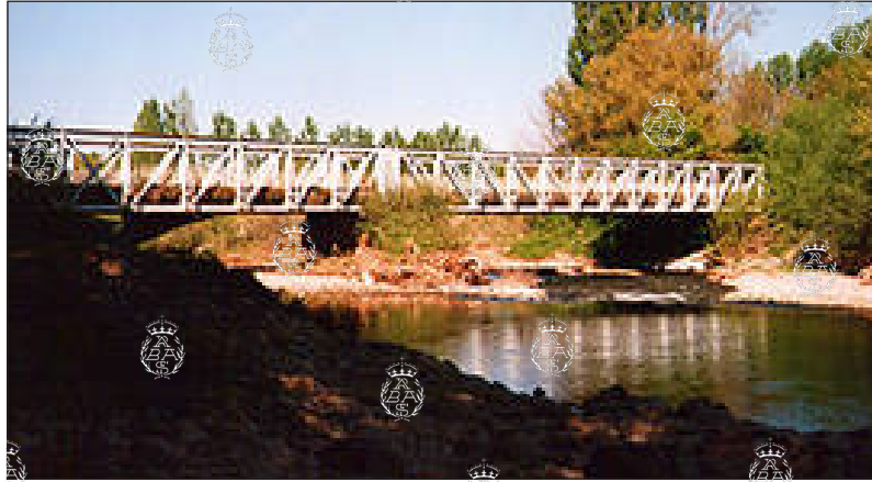
Puente metálico sobre el río Najerilla. Foto: Ayuntamiento de Arezana.
