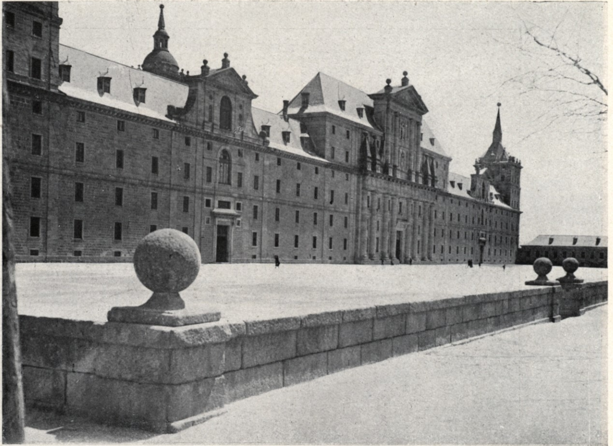
Fachada a poniente que Juan Bautista de Toledo elevara en dos plantas más, para dar satisfacción a los deseos de Felipe II.
