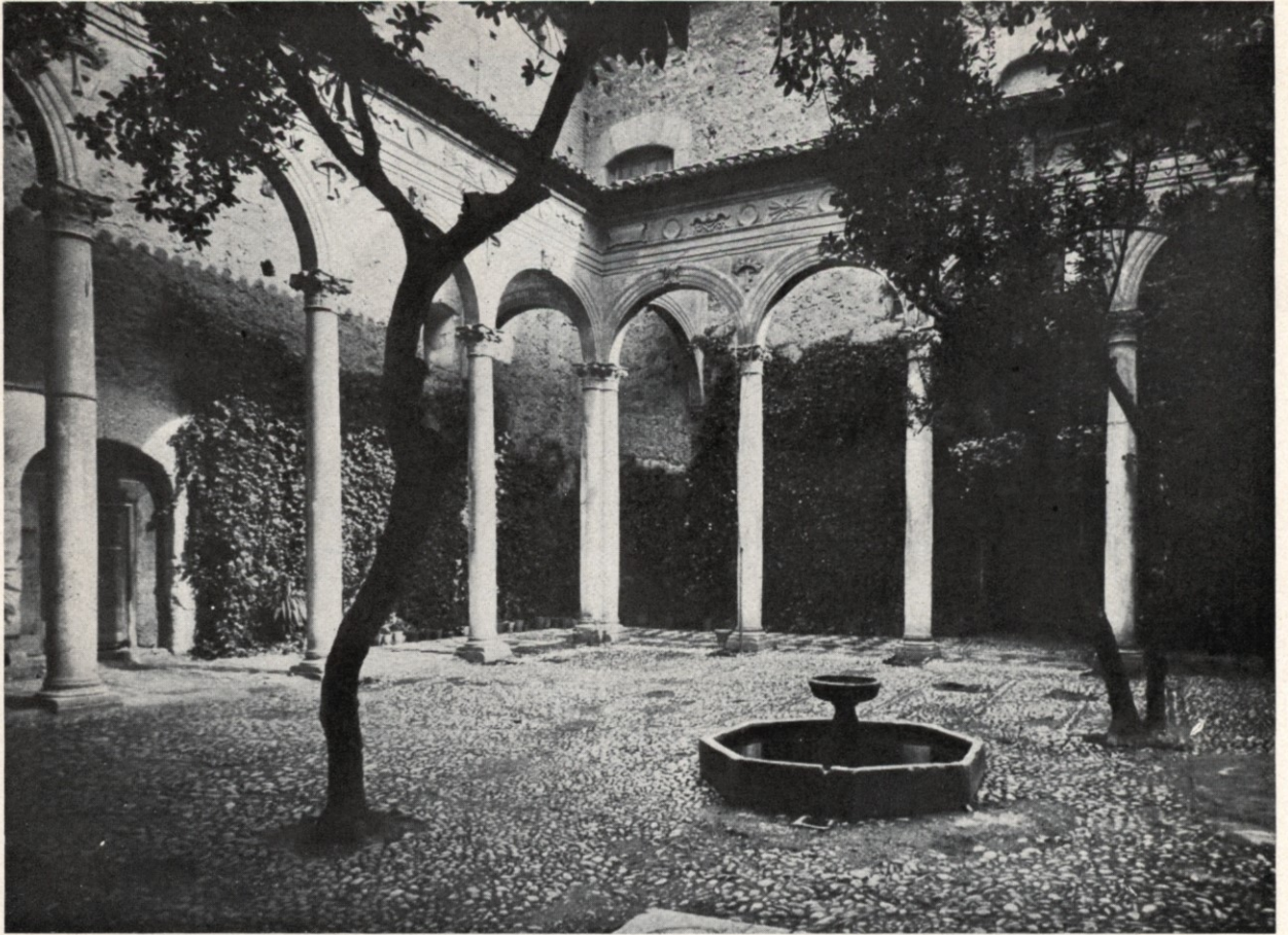
Hospital de Granada.—Claustrillo sin terminar.
