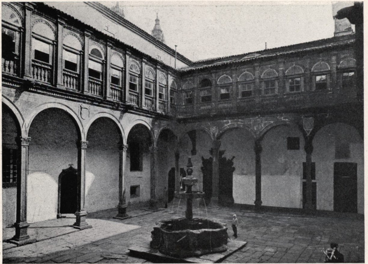
Hospital Real de Santiago.—Angulo de uno de los claustros con grandes arcos en planta baja y apilastrados y doble arco en planta alta, por cada arco de la planta inferior.
