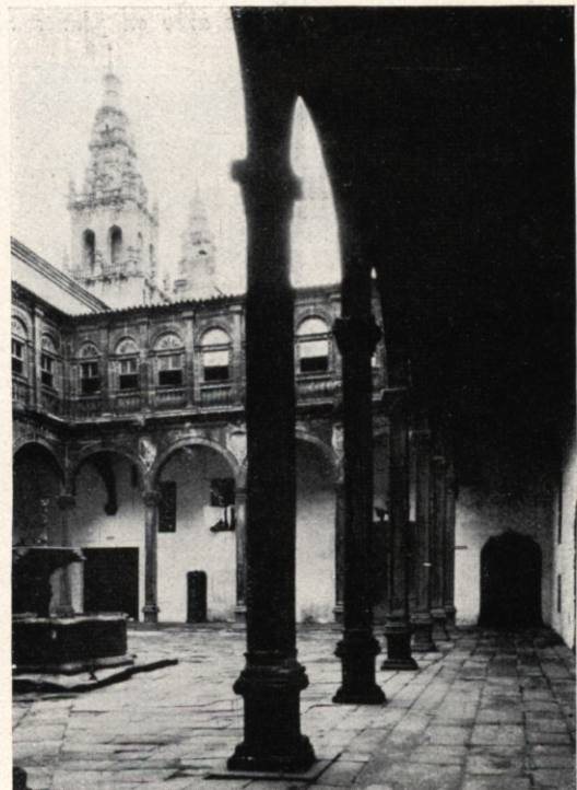
Hospital Real de Santiago.—Uno de los claustrillos con doble planta y la fuente central.
