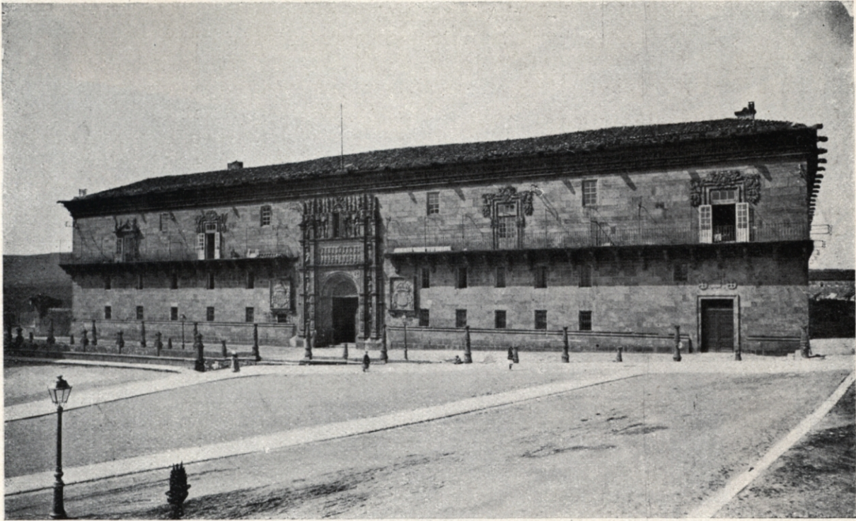
Hospital Real de Santiago de Compostela. Años 1501-1511.—Lienzo de la fachada principal, que dibujara Enrique de Egas, cerrando la unidad hospitalaria en su mitad con las modificaciones que cambiaron su aspecto, abriendo la fábrica con los balcones corridos a la vasta plaza.
