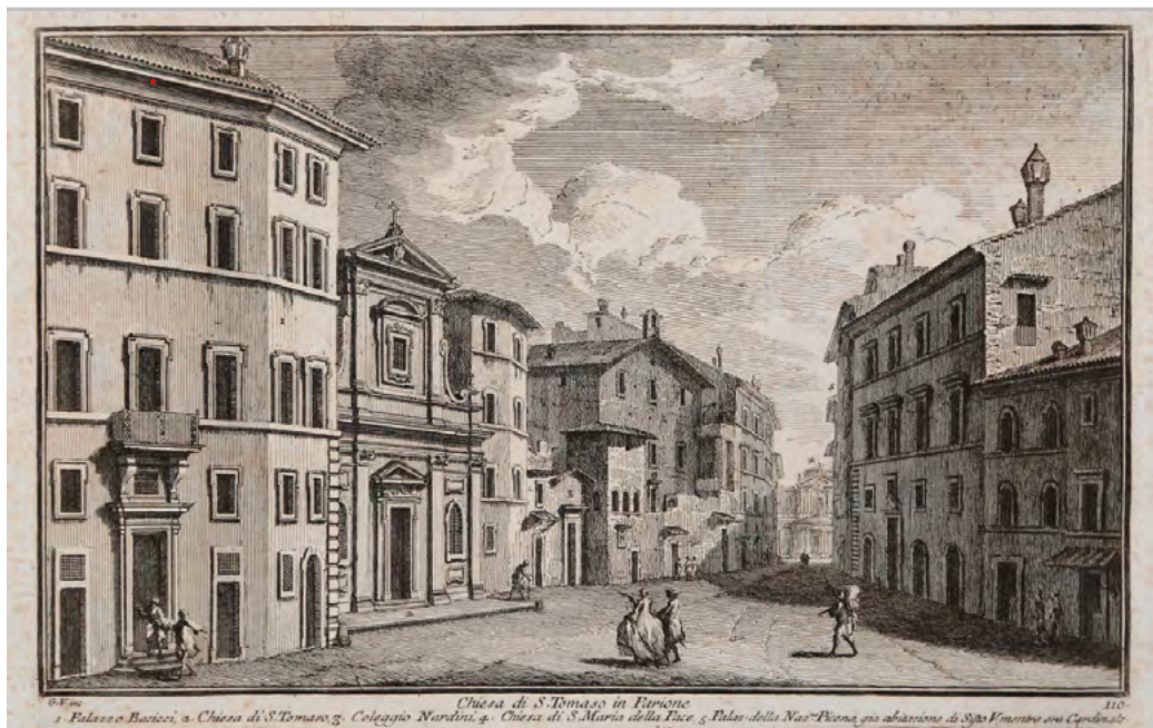
FIG. 27 GIUSEPPE VASI, Chiesa di San Tommaso in Parione , 1756 incisione, 32,2 x 21 cm. Il Collegio Nardini è l'edificio con la facciata arretrata, posto dopo la chiesa
