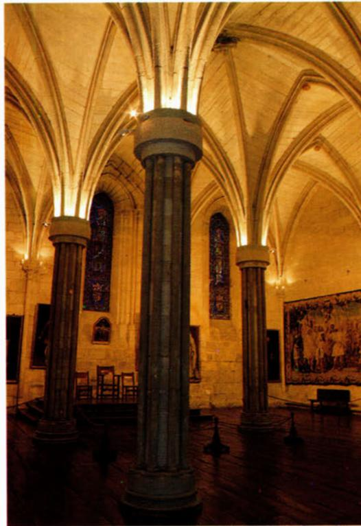
De haber sido de madera estos delgadísimos cilindros, el caso hubiera sido distinto, por la elasticidad de su composición intrínseca, que permite combarse hasta un cierto grado de flexión, sin producirse rotura no pasando de cierto límite, porque soportaría el pando y la flexión compuesta producida por la carga.
