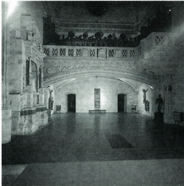
Capilla del Museo Nacional de Escultura de Valladolid. Estado de la misma antes de procederse a las obras en curso
