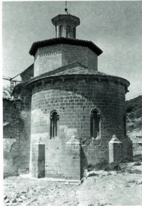
Fig. 9. Exterior del ábside, restaurado.- Se aprecian claramente las pequeñas basas que rematan los contrafuertes. Tres de ellas son originales.
