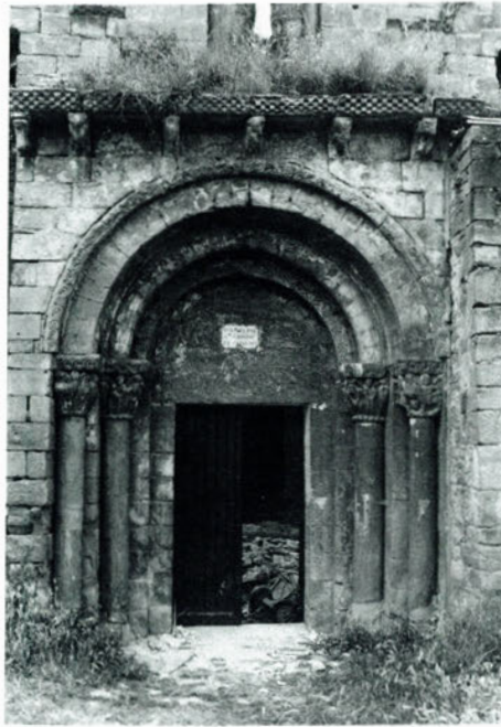
Fig. 3. Portada.- (Antes de la restauración).
