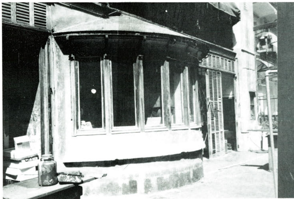
Mirador o "bow window" de la casa de los marqueses de Castellidosrius, flanqueado de persianas de librillo y con cierre por puerta corredera detrás de las siete ventanas, todo ello proyectado por Gaudí en 1901.
