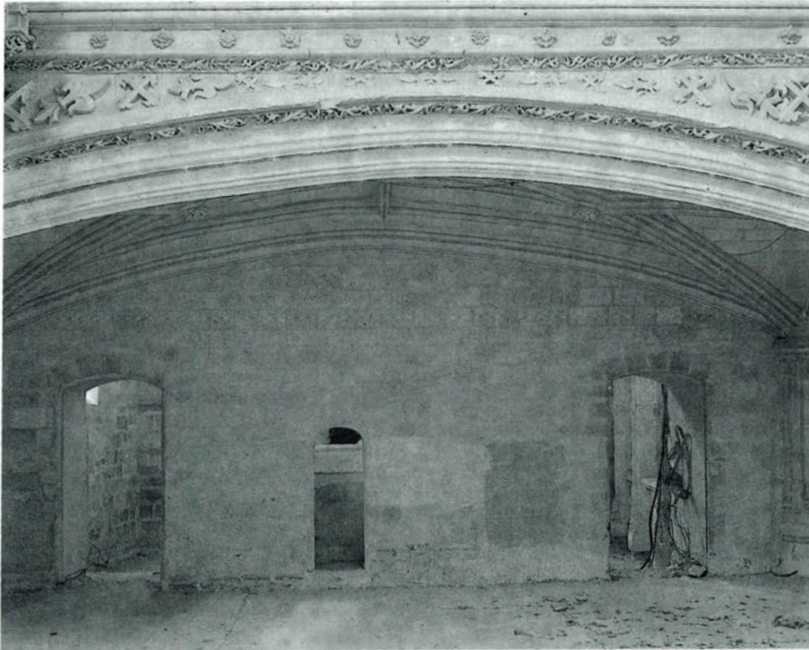
Capilla del Museo Nacional de Escultura de Valladolid. Situación durante las obras. En el centro puede percibirse que se ha descubierto la antigua puerta que da acceso a la escalera del coro alto
