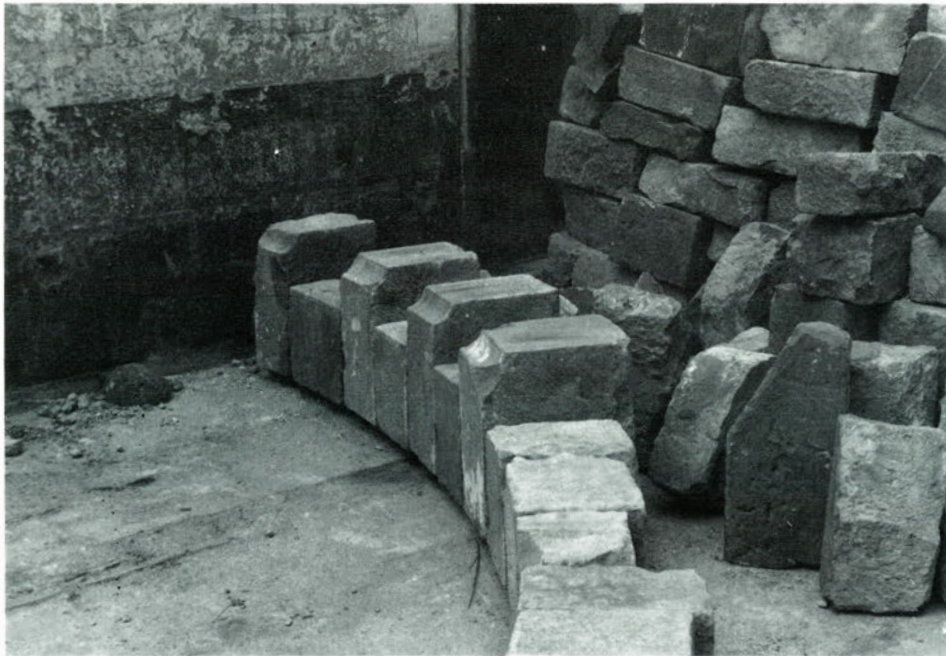
Fig. 15. Replanteo en el suelo del arco aparecido en la excavación.- Por sus dimensiones correspondía, sin lugar a dudas, a uno de los arcos de diafragma.
