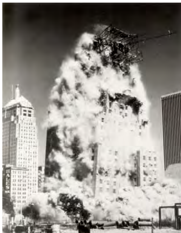
8. Anónimo. Demolición controlada del Baltimore Hotel. Oklahoma City, 1977.
