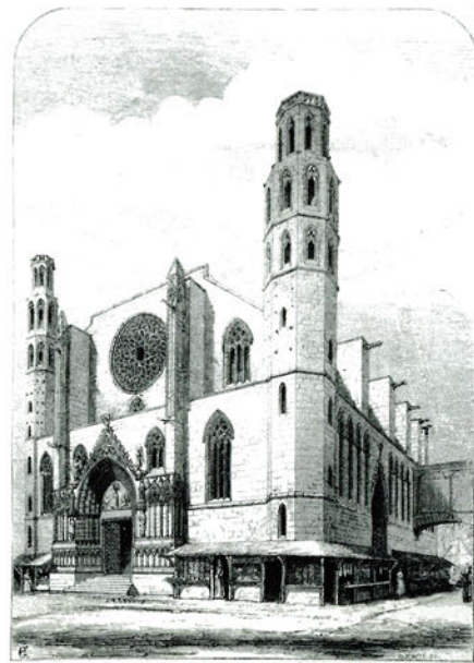
STA. MARIA DEL MAR. BARCELONA.
