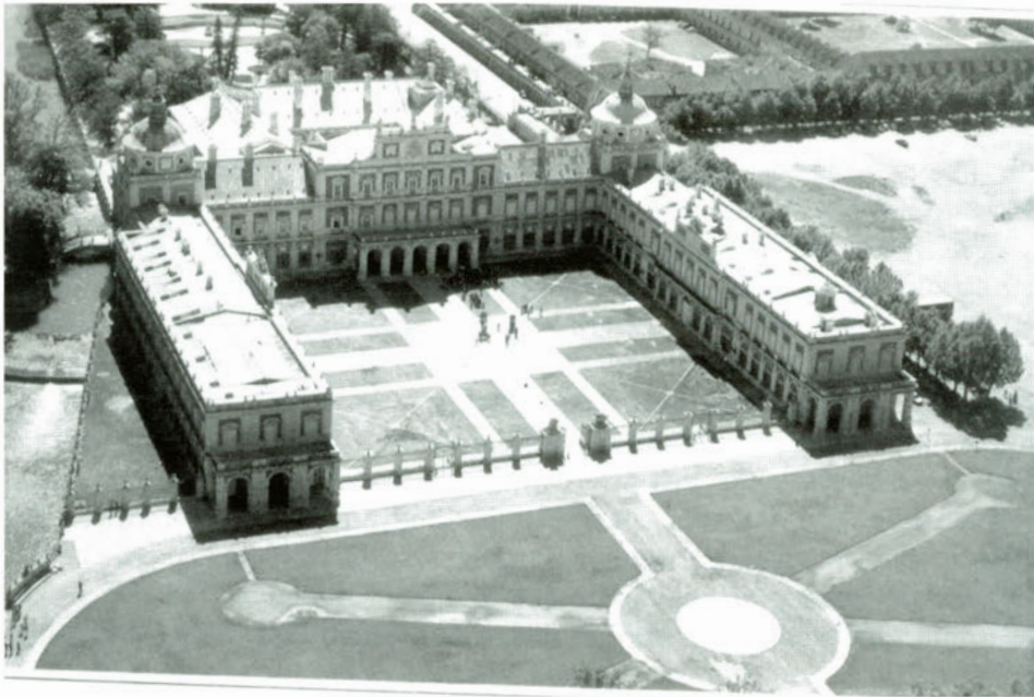
1.- El Palacio de Aranjuez. Estado actual.
