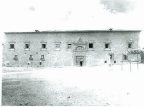
Lám. XII.- La fachada antes de las intervenciones de Arenillas. Fototeca del Archivo General de la Administración de Alcalá de Henares.
