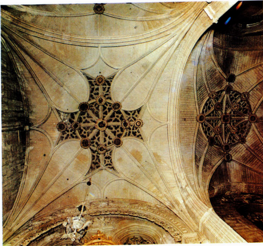
Bóvedas de la Capilla de Santiago.
