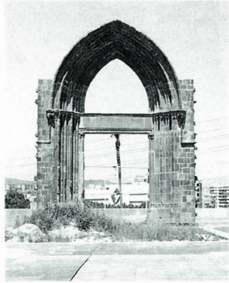
L m. 8. La puerta instalada junto al Cintur n Litoral en espera de las obras complementarias de restauraci n y jardiner a, en mayo de 1993. (Foto C tedra Gaud , 1993).
