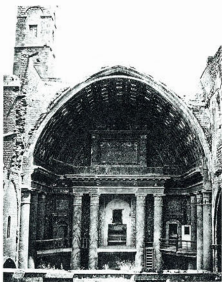
Lám. 3. Presbiterio de la iglesia del Carmen con el altar neoclásico de 1815 después del incendio de 1835. (Foto Archivo Servicio de Monumentos Diputación de Barcelona).
