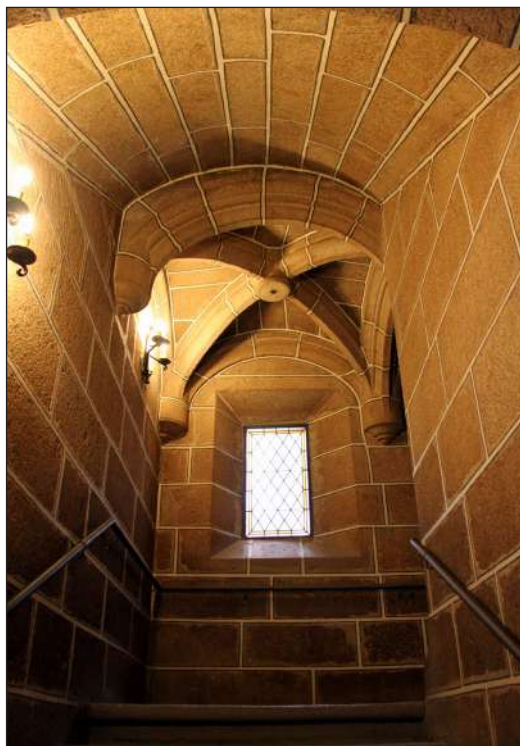
Fig. 5. Interior de la escalera principal del claustro.
