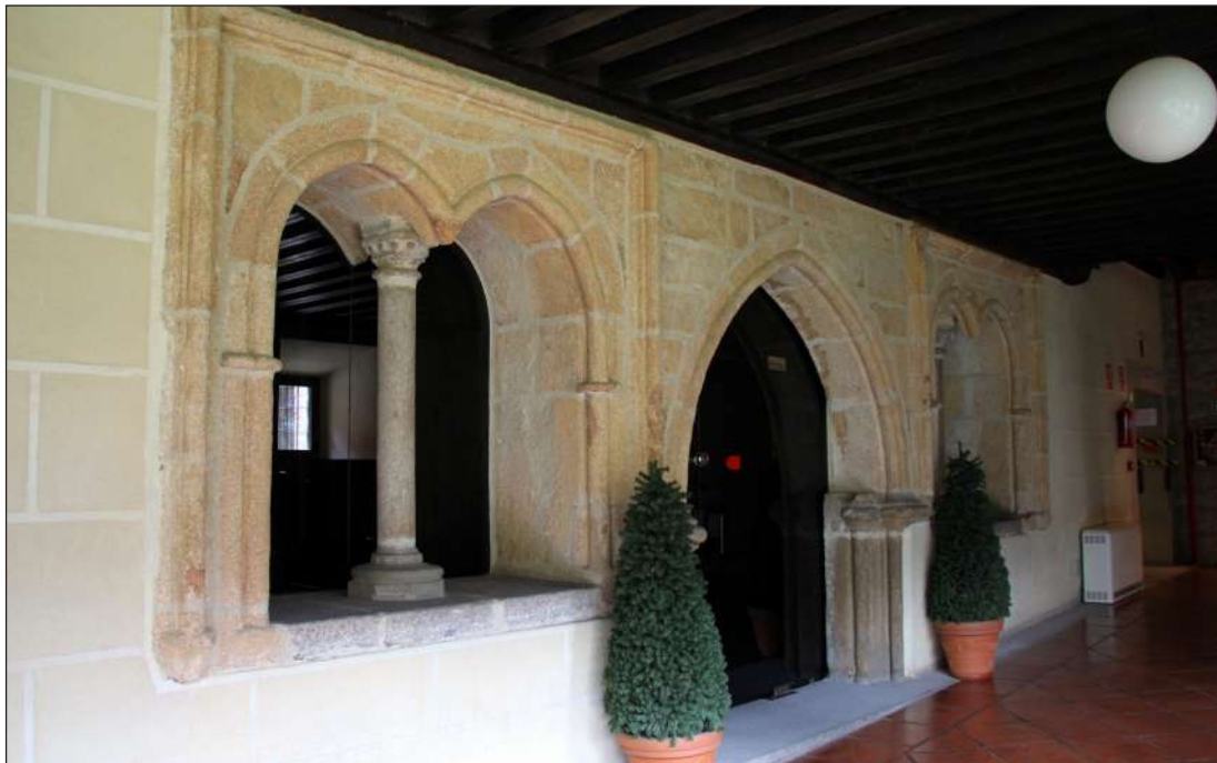
Fig. 3. Acceso a la sala capitular.
