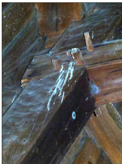
Fig. 15. Torre de vigilancia del Alcázar de Segovia, unión de tijeras y nudillos (F.A.).
