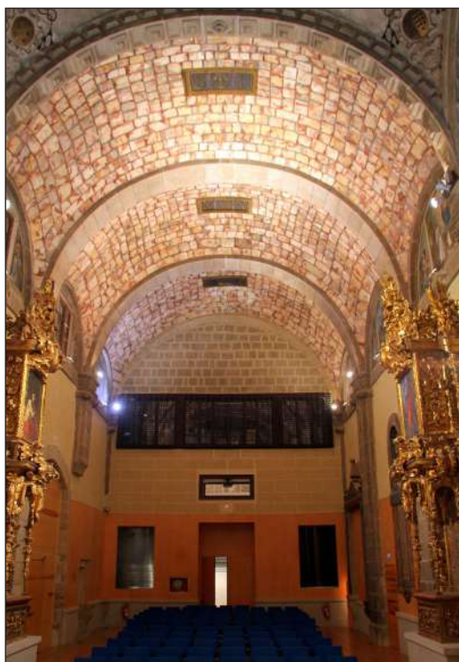
Fig. 7. Vista general de la nave.
