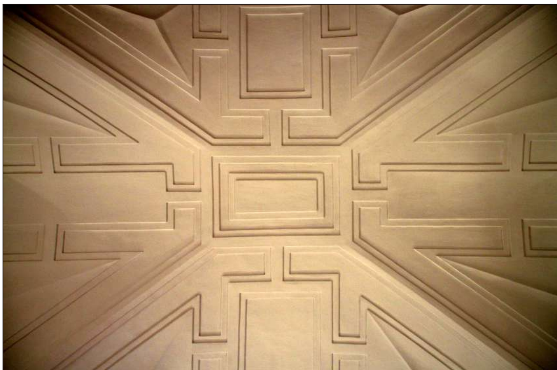
Fig. 10. Detalle de la bóveda central del coro.
